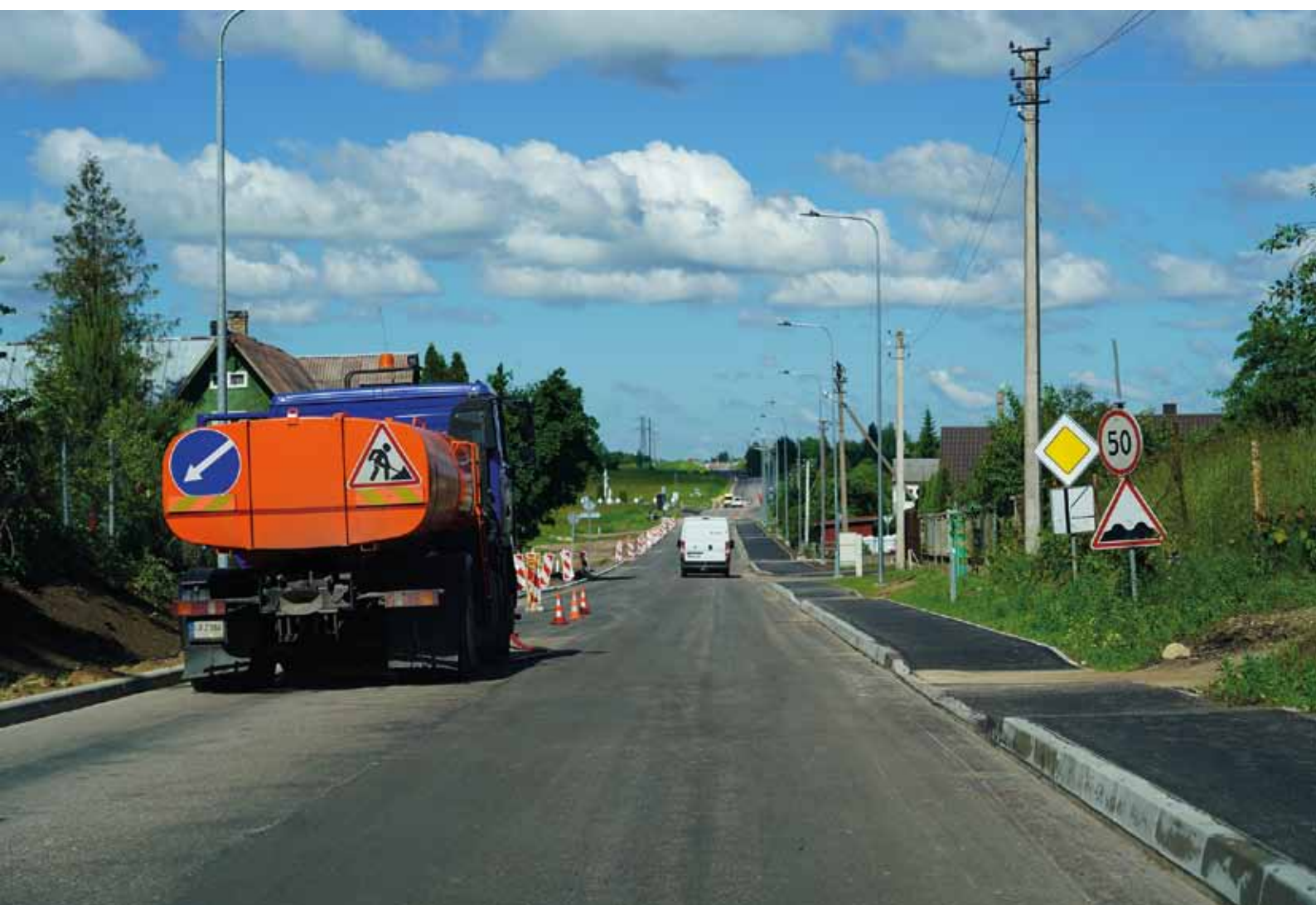
VILNIAUS G., KALVELIŲ K. REKONSTRUKCIJA, ŠALIGATVIO BEI APŠVIETIMO ĮRENGIMAS
